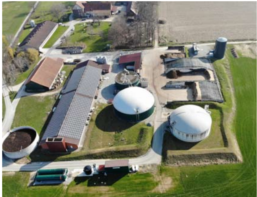
Biogasanlage mit Vapogant im Vordergrund
